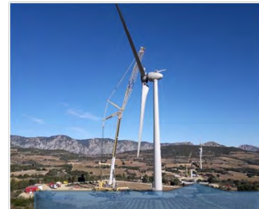
Levage du rotor
